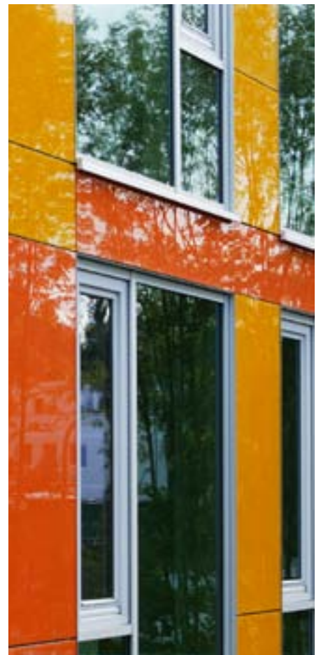
Vorgehängte hinterlüftete Fassadendämmsysteme
