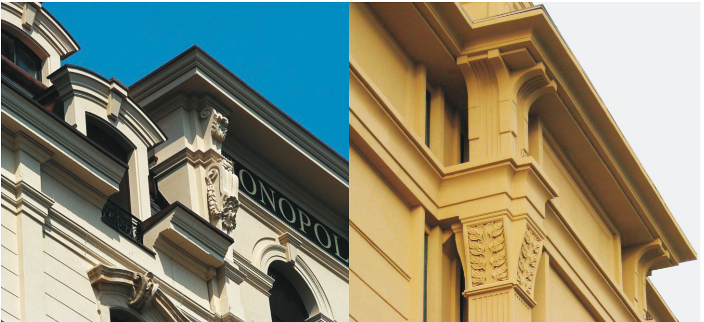
г. Санкт-Петербург, Лиговский проспект, ТЦ «Галерея». В отделке фасада использовались StoDeco Profile, система утепления StoTherm Mineral и краска Lotusan.
